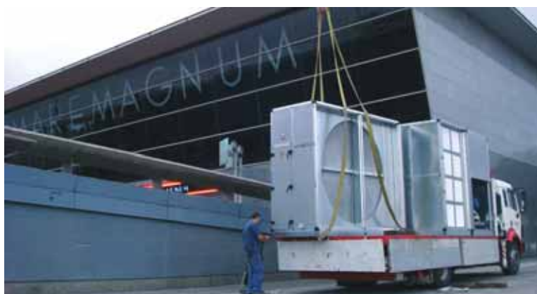
Centro Comercial MAREMAGNUM (Barcelona) Recuperador rotativo 35.000 m 3 /h
