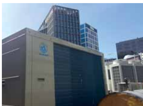
Centro Comercial Glories (Barcelona) Enfriadora Inverter 60 kW
