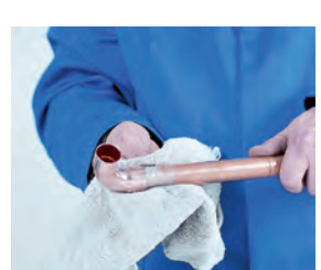
6. Limpieza final 6. Limpeza final
