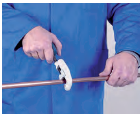
1. Corte de tubo 1. Cortar o tubo
