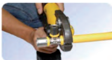
4 - Prensado de tubo y accesorio. Utilizar mordazas tipo "U". 4 - Prensar o tubo e o acessório, utilizando mordazas do tipo "U"
