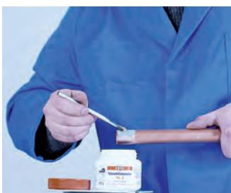
4. Aplicación del decapante 4. Aplicação do decapante
