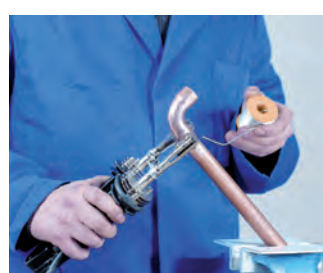
5. Aplicación de la soldadura 5. Aplicação da soldadura
