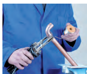
5. Aplicación de la soldadura 5. Aplicação da soldadura
