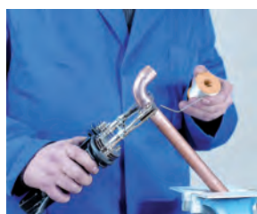
5. Aplicación de la soldadura 5. Aplicação da soldadura
