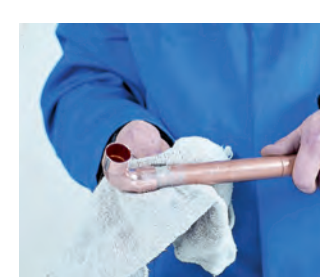
6. Limpieza final 6. Limpeza final
