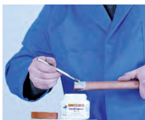
4. Aplicación del decapante 4. Aplicação do decapante
