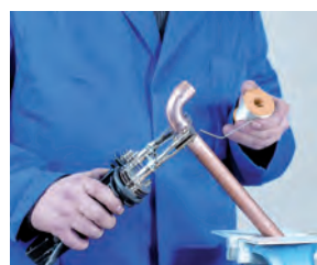
5. Aplicación de la soldadura 5. Aplicação da soldadura
