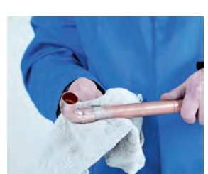
6. Limpieza final 6. Limpeza final
