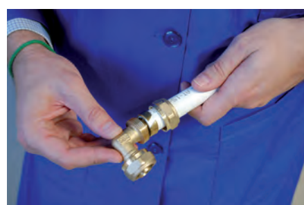
3. Acoplar tubo y accesorio según se muestra 3. Acoplamento de tubos e acessório, como mostrado
