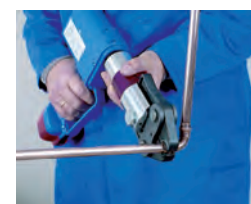
6. Prensado 6. Prensado
