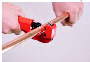
1. Corte de tubo 1. Cortar o tubo
