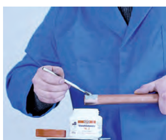
4. Aplicación del decapante 4. Aplicação do decapante
