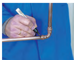
5. Marcar la inserción 5. Marcar o ponto da inserção
