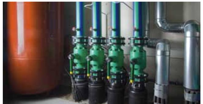
Las redes de tuberías, en agua caliente, deben ser proyectadas e instaladas con tuberías compuestas MF (faser) aquatherm blue pipe.
