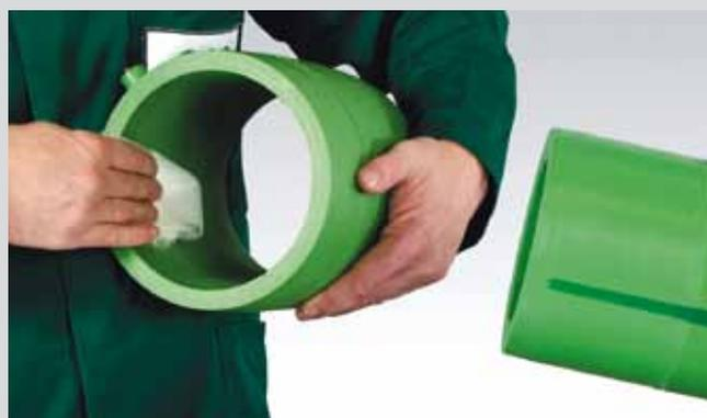
Limpiar la cara interior del manguito de electrofusión, empleando un paño o papel que no deje residuos. Eliminar la humedad que puede aparecer, **inmediatamente antes de iniciar el proceso de soldadura.**
