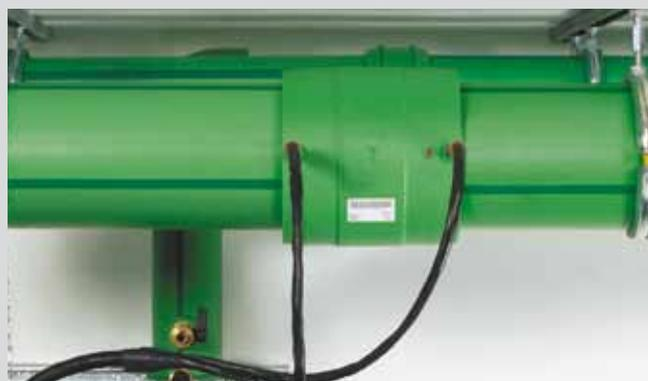
Ajustar la máquina de soldar a la profundidad de soldadura del manguito electrosoldable. Soldar, dejar enfriar. ¡Listo!
