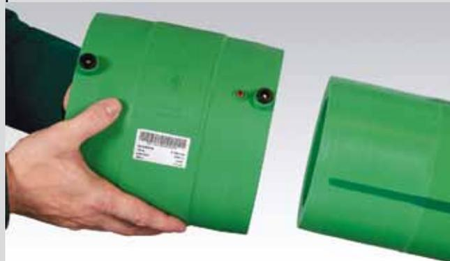
Introducir el manguito electrosoldable hasta la profundidad marcada
