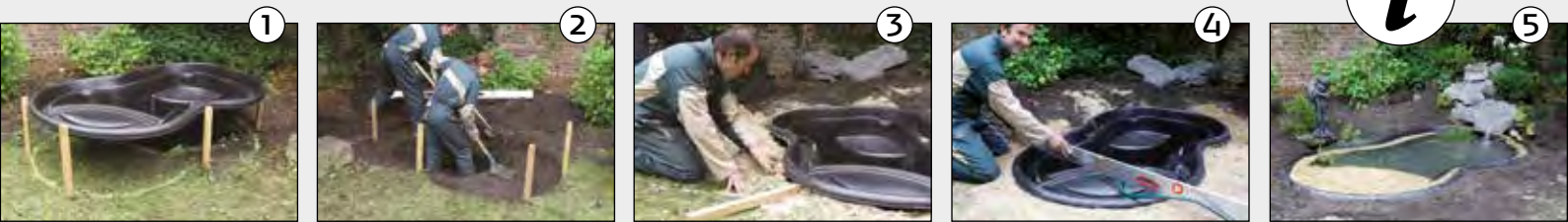
Pasos para la instalación de estanque prefabricado
