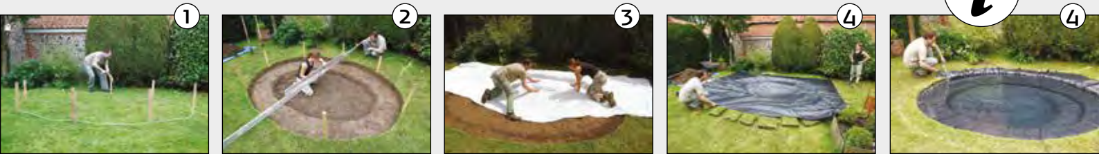
Pasos para la instalación de estanque en láminas
